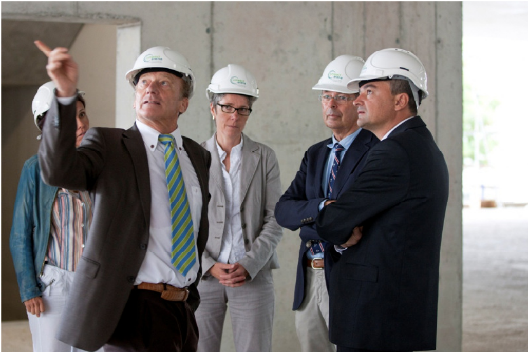
Legende: Besichtigung der Baustelle im Rahmen der Vertragsunterzeichnung: v.l.n.r Walter Schmid, Initiant und Verwaltungsratspräsident Umwelt Arena AG; Katharina Teuscher, Geschäftsführerin/Leiterin Kommunikation und Marketing Umwelt Arena; Jürg Peritz, Stv. Vorsitzender der Geschäftsleitung Coop; Joos Sutter, designierter Vorsitzender der Geschäftsleitung Coop;
